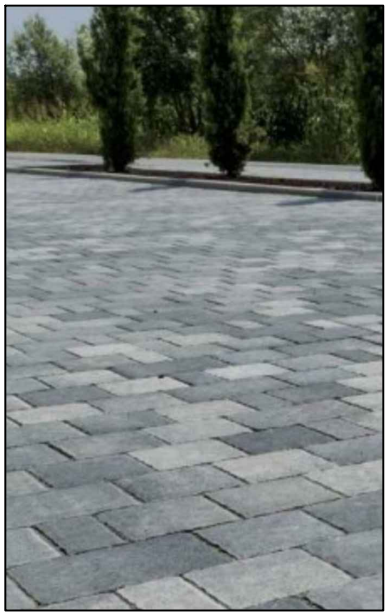
Foto 1 - Pavimentazione percorsi pedonali in autobloccanti
