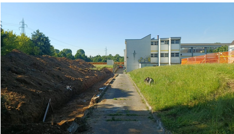
Iqbal Masih – Lavori sul vialetto
