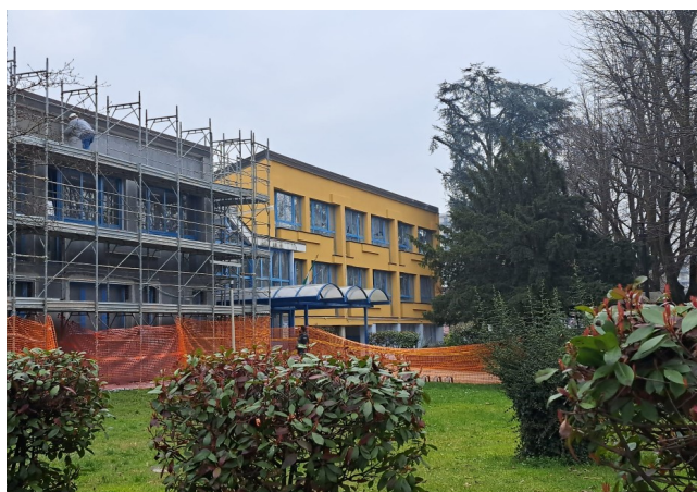
Primaria via Bizet 3/A – applicazione cappotto
