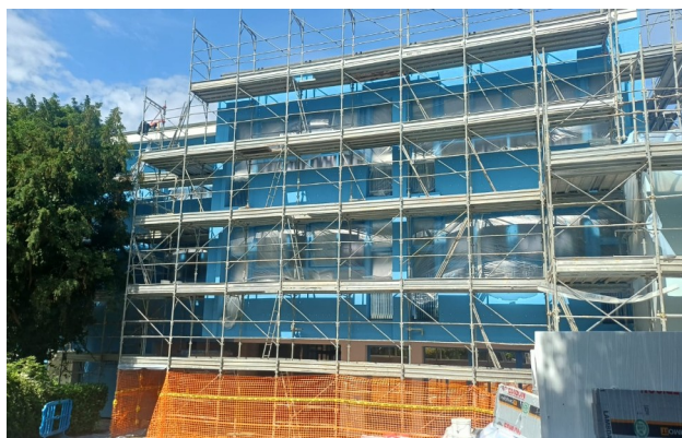
Secondaria via Bizet 1 – applicazione cappotto
